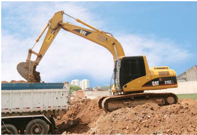
Carregamento do entulho, troca de solo e espalhamento de rachão é feito pela 315CL
