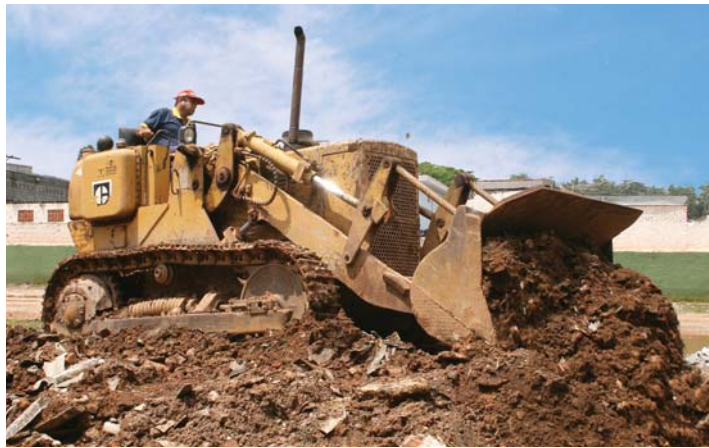
Carregadeira de esteiras 941B prepara camada intermediária antes da aplicação de concreto usinado
