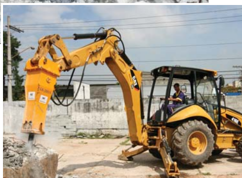
416E equipada com rompedor hidráulico quebra o piso da edificação existente
